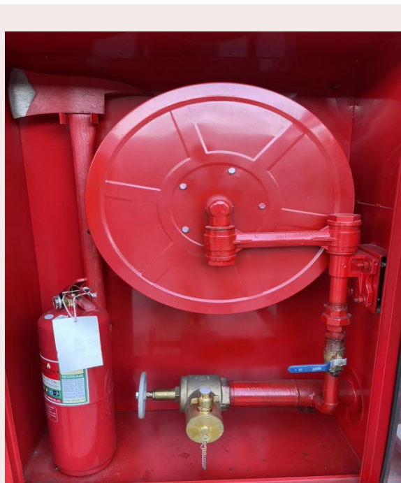
รูปที่ 2.4.6.1-2 ตู้เก็บสายน้ำดับเพลิงพร้อมอุปกรณ์
